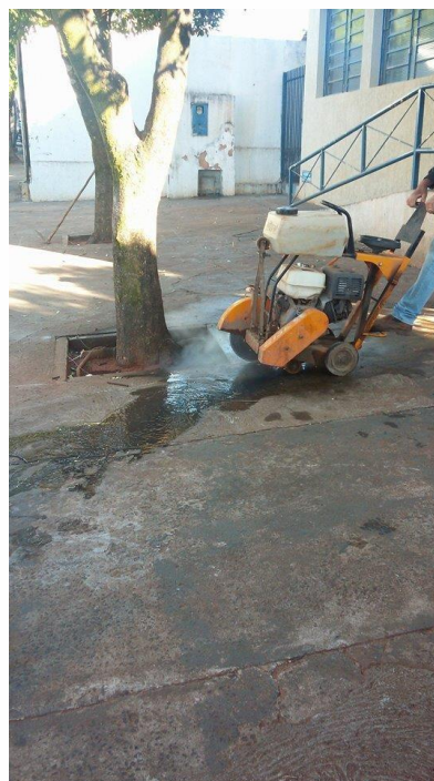
Figura 7: Corte da calçada
